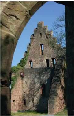
Der Stufengiebel mit den massiven Maueransätzen ist der letzte obertägige Rest eines großen Herrschaftsgebäudes. Foto: Eleonore Schuch
